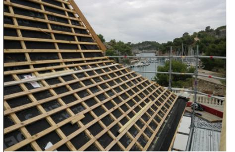
La charpente est terminée. Couverture du château (pose de tuiles en cours).
